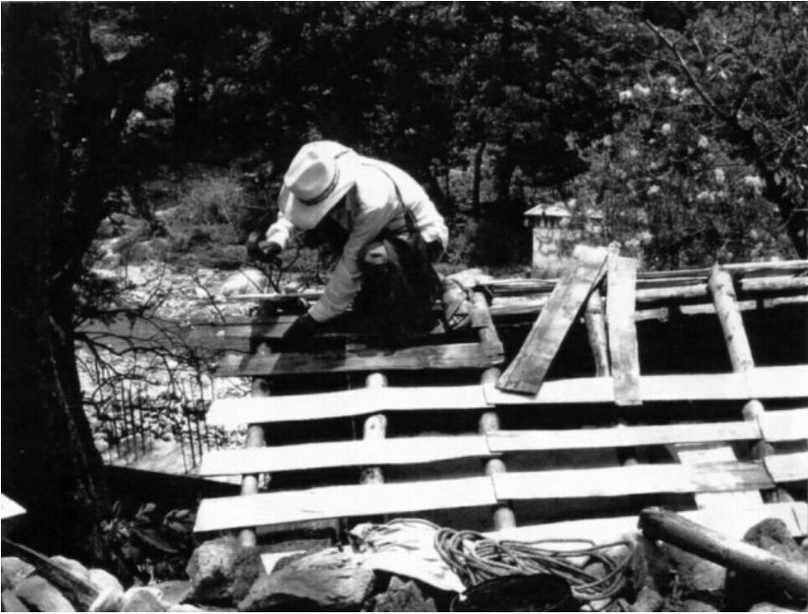
La reparación de un techo
