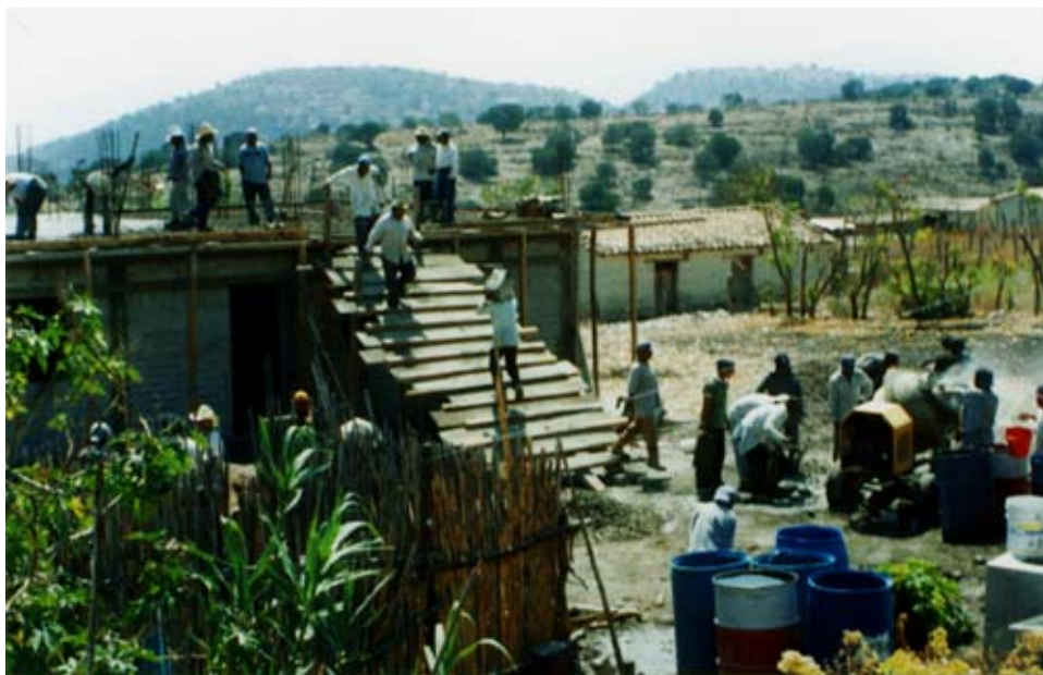
Colando el techo.
