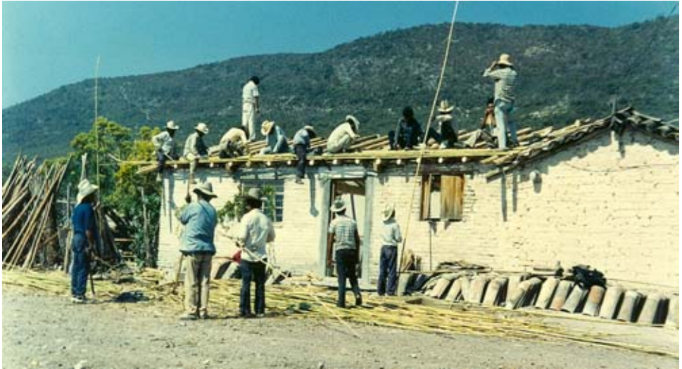
Construyendo un techo nuevo.
